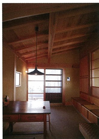
現し工法施工例
